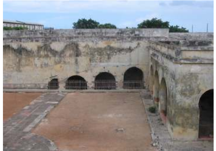
FIG. 1. Bóvedas bajo la rampa utilizadas, entre otros fines, como letrina, donde se realizaron las excavaciones arqueológicas
