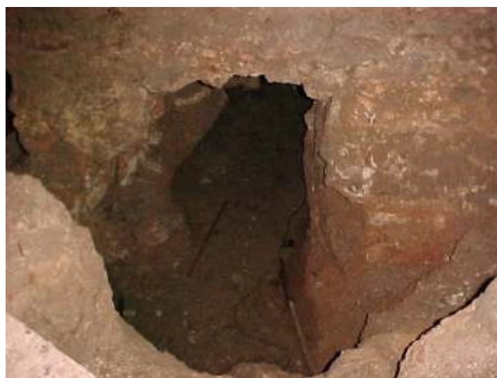
FIG. 4. Entrada del conducto de la Zanja Real en el subsuelo de la casa de San Ignacio # 68
