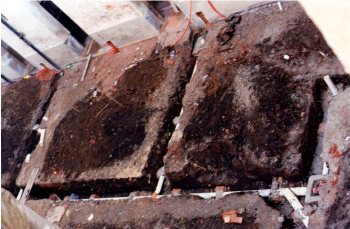
FIG. 2. El lugar del hallazgo en el cruce central de cañerías del claustro
