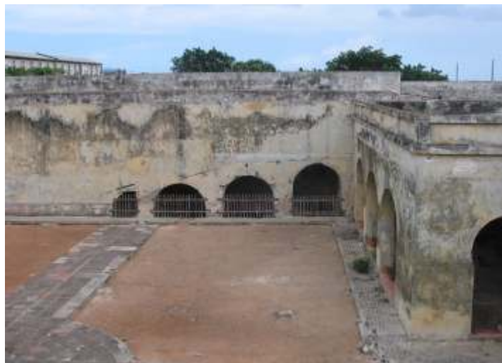
FIG. 1. Bóvedas bajo la rampa utilizadas, entre otros fines, como letrina, donde se realizaron las excavaciones arqueológicas
