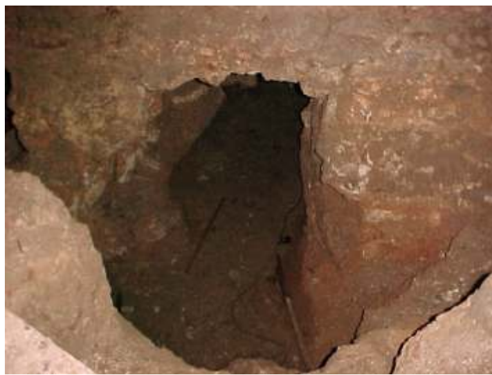
FIG. 4. Entrada del conducto de la Zanja Real en el subsuelo de la casa de San Ignacio # 68
