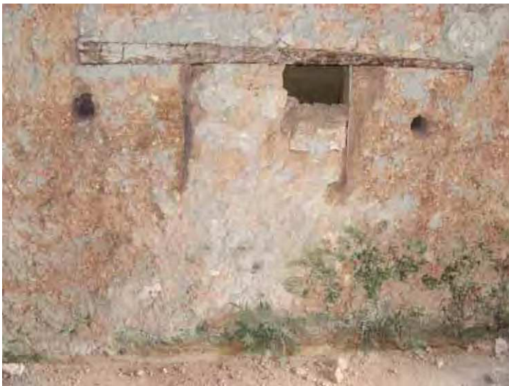
FIG. 3. Vano tapiado en el local AB 13-14
