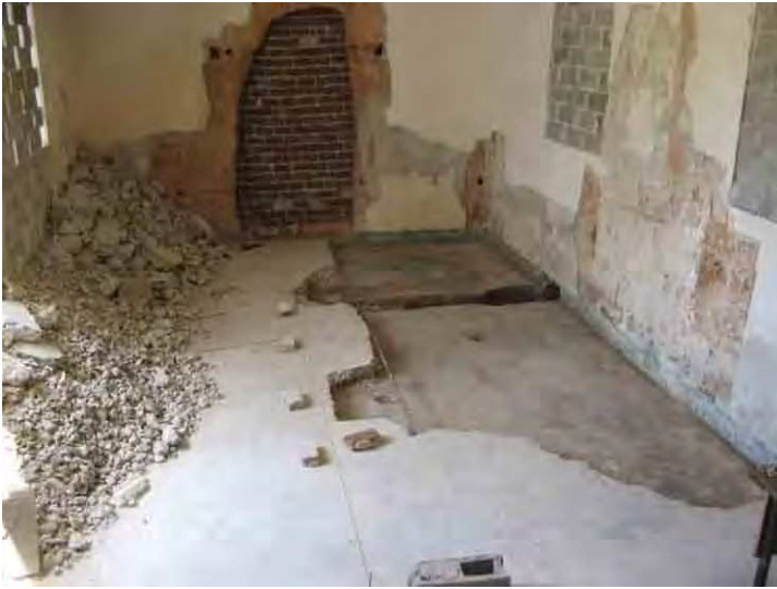
FIG. 8. Vista del local desde el muro 11. Nótese el nivel de piso de ocupación de enlucido de cal y la huella en el tapial del retablo, así como el rodapié de pintura azul
