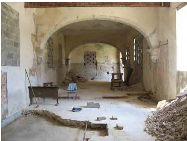
FIG. 4. Vista del local AB 11-13 desde el extremo oeste, donde se aprecian los dos arcos que lo distinguen
