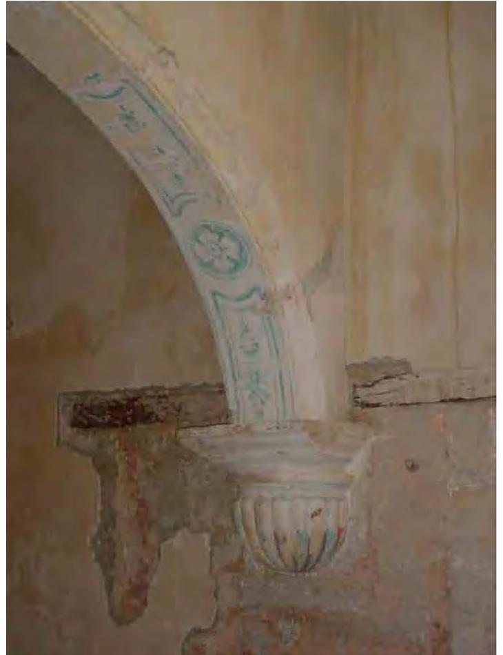
FIG. 6. Vista del arranque del arco oeste donde se aprecia el vano tapiado y el dintel cortado
