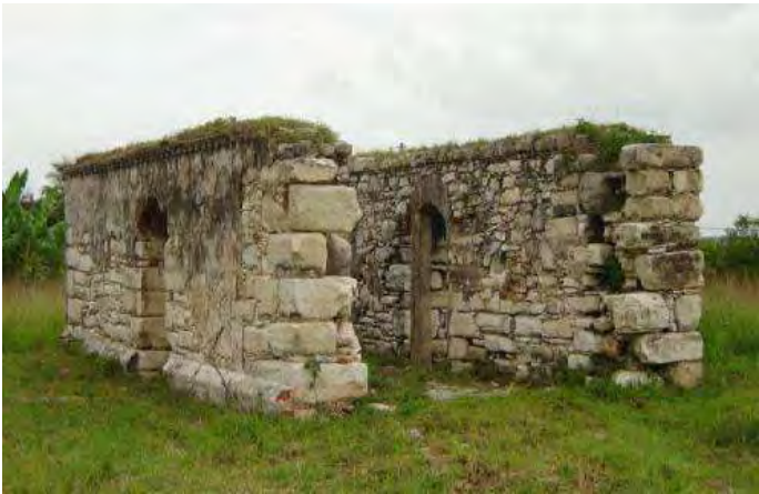
Fig. 12. Vista parcial de las estructuras que se conservan del ingenio Triunvirato
