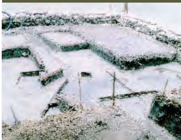
Proceso de Excavación
