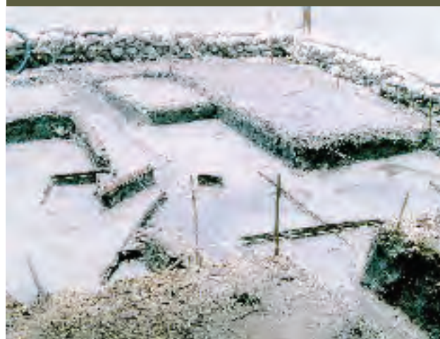
Proceso de Excavación
